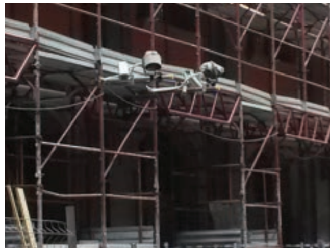
Ponteggi e relativi dispositivi di sicurezza anticrimine | Scaffolding with crime-prevention devices
